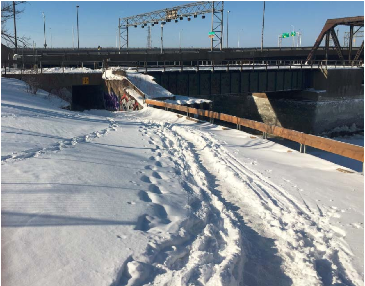
Photo 2 – 9 janvier 2017, entrée du tunnel sous le pont Samson
