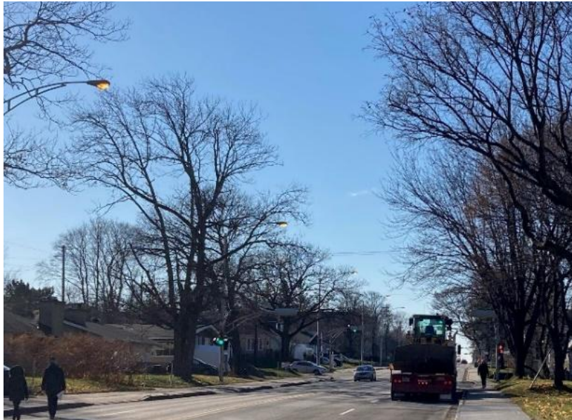
Photos 4-5-6 : Trottoir très étroit et attenant à la chaussée. Impression pour les piétons de marcher dans la rue. Au moindre faux mouvement, des personnes vulnérables (enfants, personnes âgées) pourraient se faire frapper.
