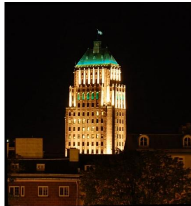
Édifice Price alors que sa mise en lumière était pleinement fonctionnelle. Crédit photo : CCNQ
