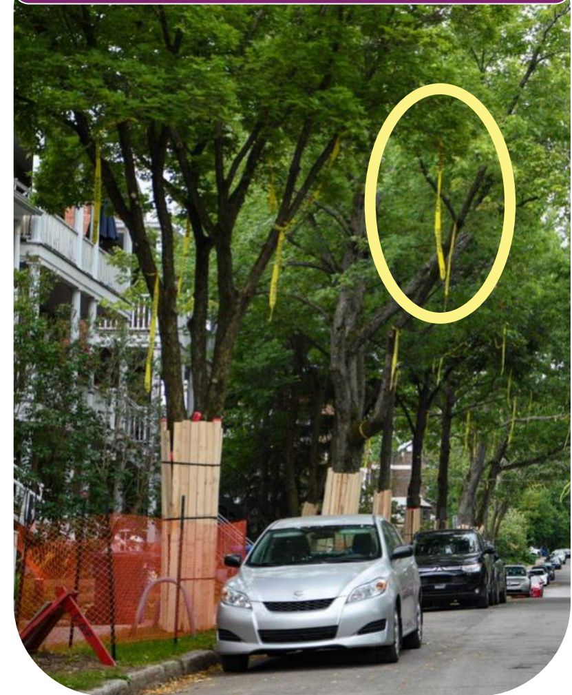
3. Dégagement de la zone des travaux - Repère visuel (sur chantier)
