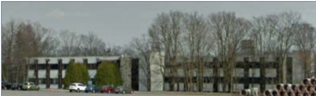
Figure 29 : Édifice de la Faune, 9530 rue de la Faune, Québec, mai 2015 (démoli en 2019).
