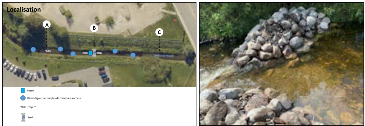
Figure 49 : Fosse, frayère et seuil aménagés dans la rivière du Berger par l'organisme de bassins versants de la capitale, 30 et 31 août 2023.
