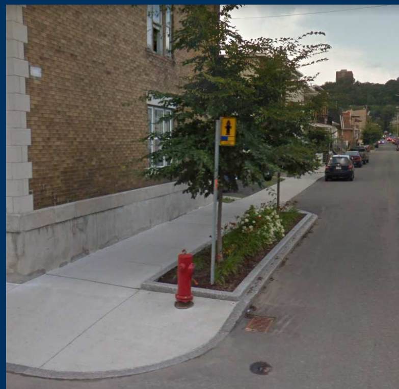
Gonflement de trottoir Rue Anna
