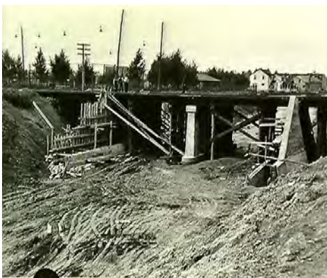
Construction du viaduc croisant la 18e Rue, 1944
