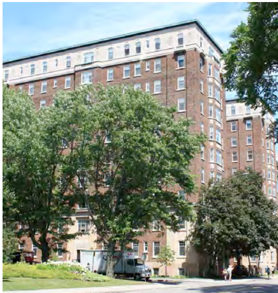
Le Claridge , érigé par les architectes Robitaille et Desmeules en 1928 pour le notaire R. E. McKay. Le plan en H, qui favorise un éclairage adéquat de tous les appartements, caractérise l'immeuble de dix étages d'influence Art déco 16 . 220, Grande Allée Est.
