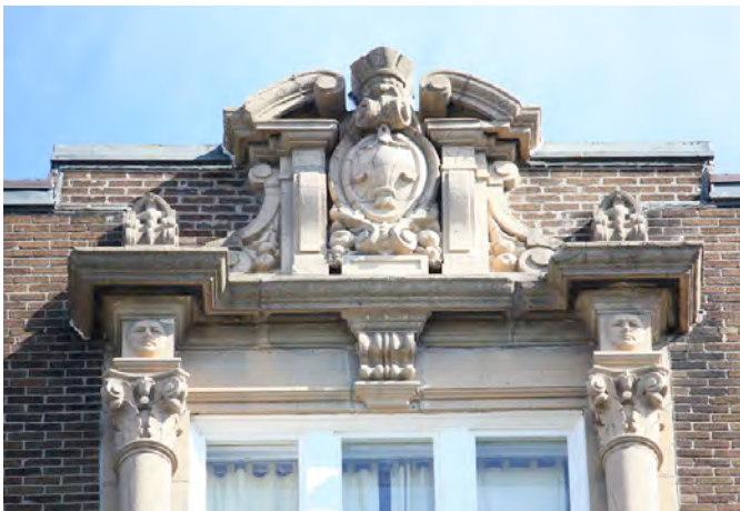
Imposants motifs avec corniche et pilastres au sommet du Château Saint-Louis , des éléments empruntés au baroque anglais. 135, Grande Allée Est. IMG_6317.jpg
