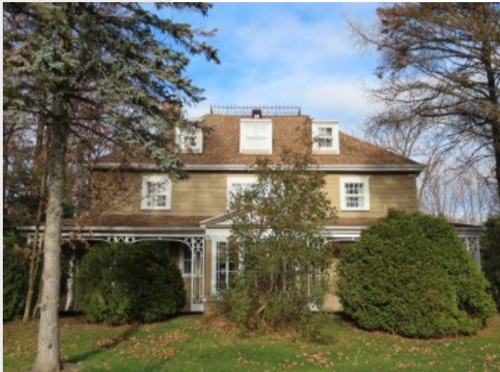
Villa Spencer Grange, 1328, avenue Duquet (Néoclassique, 1844)
