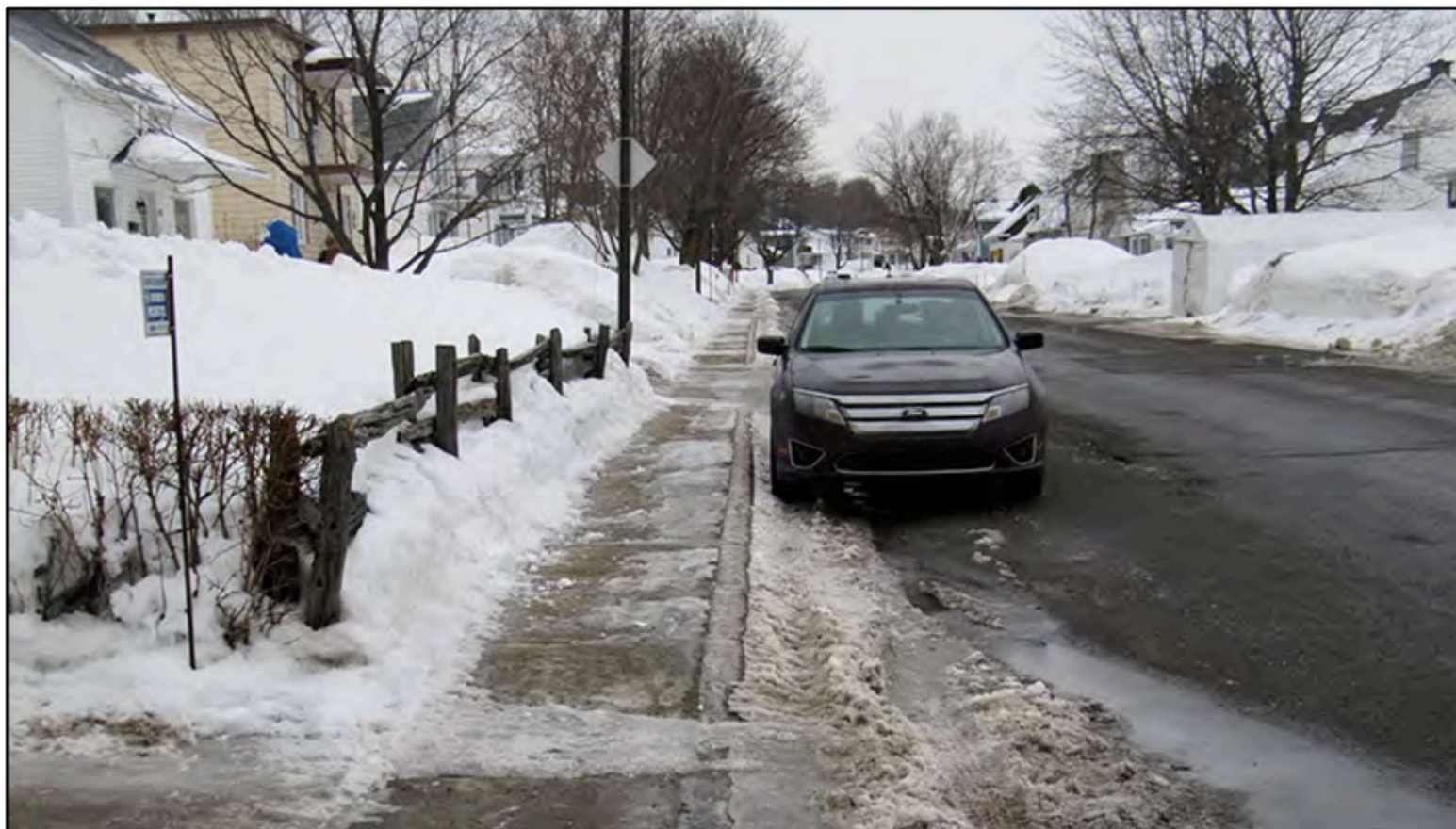
Figure 38 Le trottoir sur le boulevard des Français est d'une largeur insuffisante pour permettre un bon déneigement lorsqu'une voiture est stationnée en bordure de la chaussée.
