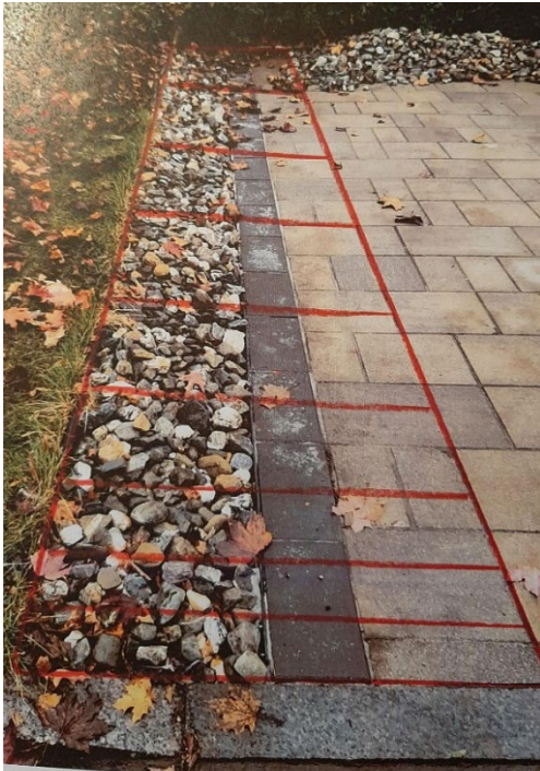
La photo, lignes rouges, montre la perte de terrain occasionné par les travaux de réaménagements.
