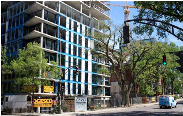
Condominiums L’Étoile . IMG_5647.jpg
