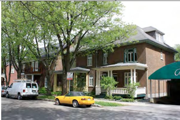
Entre les avenues Galipeault et Briand. IMG_5190.jpg
