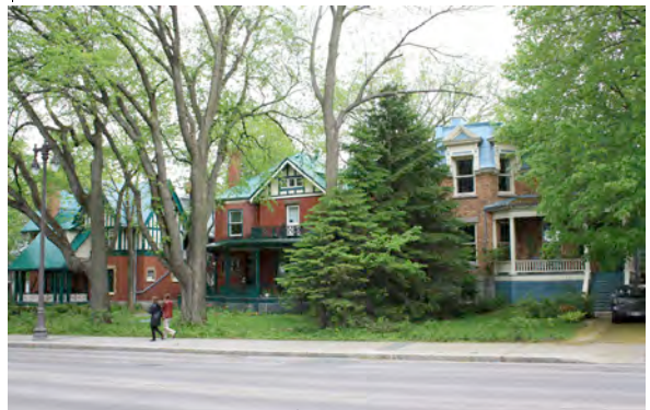
Entre du Parc et des Érables. IMG_5167.jpg
