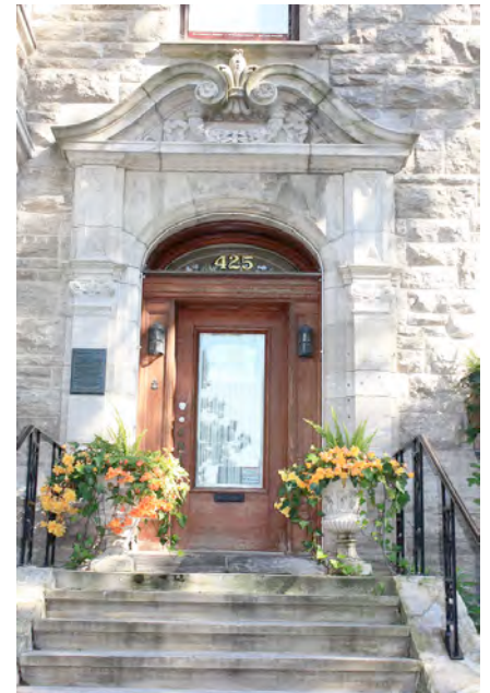
Encadrement monumental en pierre avec pilastres et fronton arqué. 425, Grande Allée Est. IMG_6338.jpg
