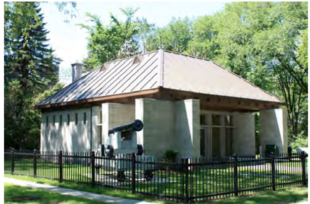
Immeuble abritant des toilettes publiques, avenue du Parc. IMG_6100.jpg
