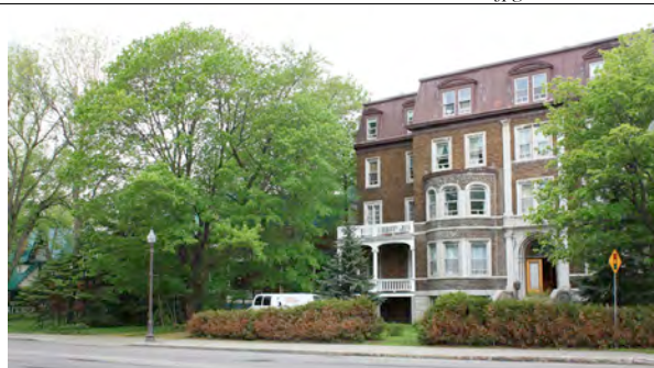
Entre du Parc et des Érables. IMG_5168.jpg
