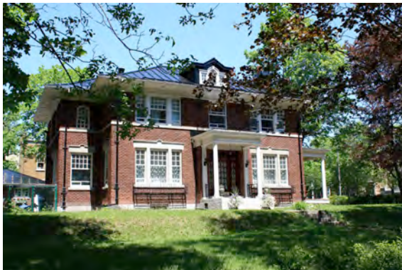
Entre des Braves et des Laurentides. IMG_5677.jpg
