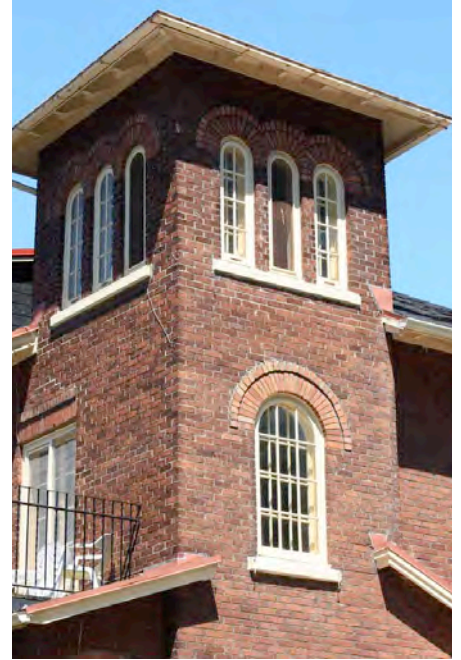
Tourelle et fenêtres en arc plein cintre, des détails d'architecture d'inspiration néo-romane. 200, rue De Bernières, Héliodore Laberge, architecte (vers 1922). IMG_6013.jpg
