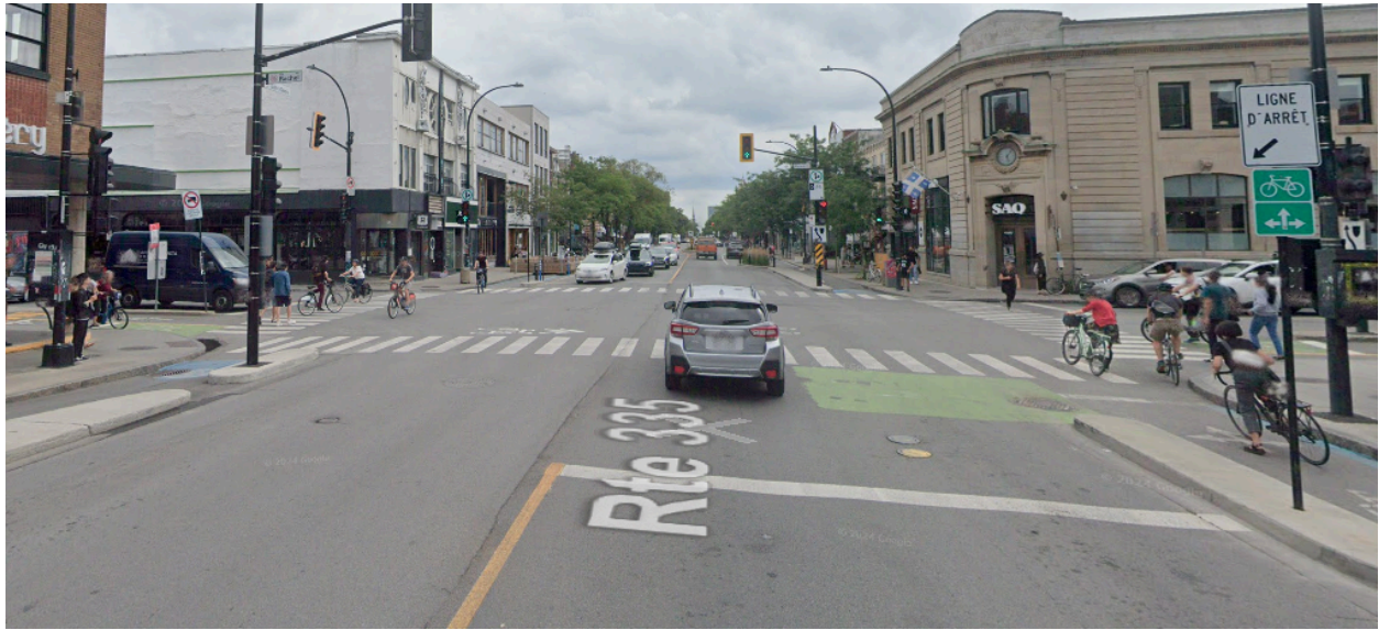
Figure 3-A : Les feux avec phase piétonne, cycliste et voiture concourantes commencent avec une phase où les piétons et les vélos peuvent circuler dans l'axe (feux piétons et cyclistes séparés à droite de la photo) et les conducteurs de voiture doivent circuler tout droit ou attendre pour le droit de virage (feu en flèche verte indiquant les mouvements permis et prioritaires)
