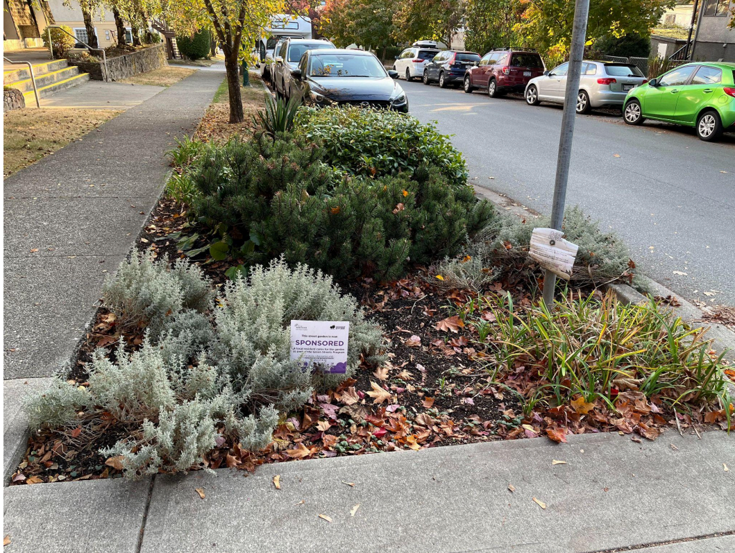
Figure 4-B. Une avancée de trottoir à Vancouver délimite la zone d'interdiction de stationnement tout en servant de petit jardin communautaire. Les végétaux ont un profil bas. Photo: Nadia Aubin-Horth
