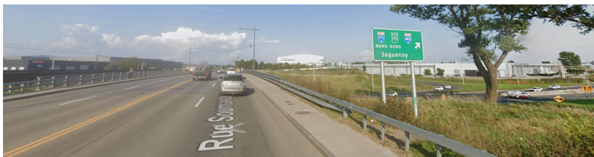
Image 6.1 : Le viaduc de la rue Soumande et l'échangeur autoroutier en plein cœur du pôle urbain. (source - Google Street View - 2025)
